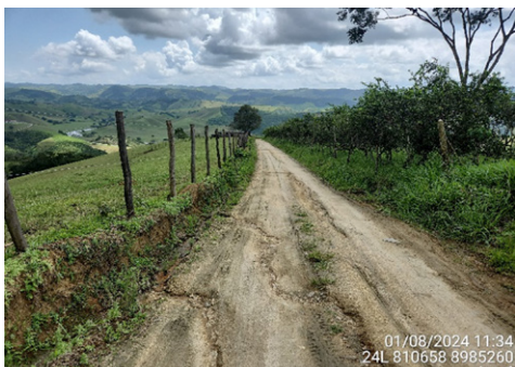
Via de acesso principal a comunidade Barro Branco, Santana do Mundaú/AL.
